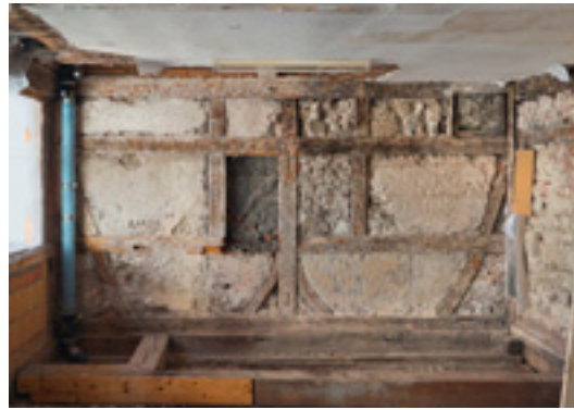
4 Das am vollständigsten erhaltene Teilstück des Fachwerkgerüsts im Obergeschoss mit früherem Doppelfenster, das durch anstoßende Gebäude vor Veränderungen bewahrt blieb.
