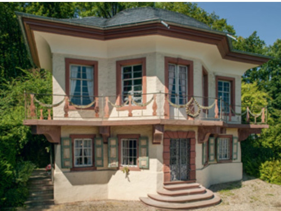
1 Mauer, Schlösschen „Sorgenfrei“, Ansicht von Nordost.
