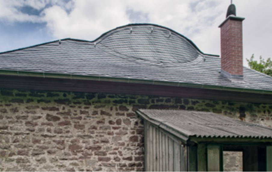
8 Rückseitige Ansicht von Schieferdeckung, neuem Kaminaufbau und überdachtem Eingang zur Beletage.
