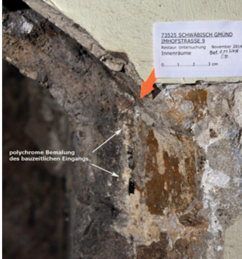
aus werkmäßig zugearbeitetem Quarzsandstein bestehende Quadermauerwerk setzt sich als geringer dimensioniertes Mischmauerwerk aus Angulatsandstein, Backstein und einzelnen Quarzsandsteinen nach oben fort.
