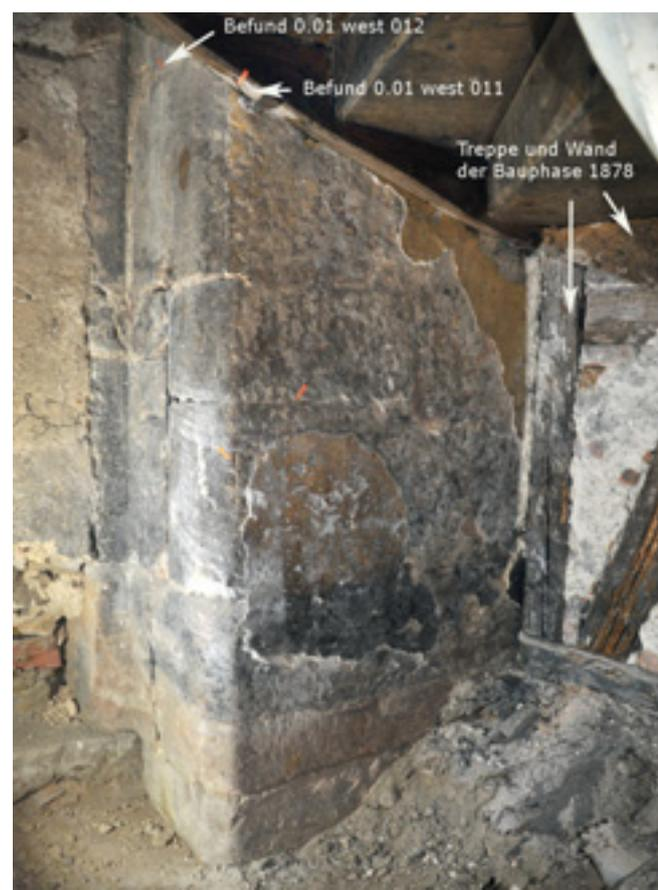
1 Nordseitiges Mauerwerk des ehemaligen Westeingangs mit Befunden zur Architekturoberfläche der Bauzeit.
