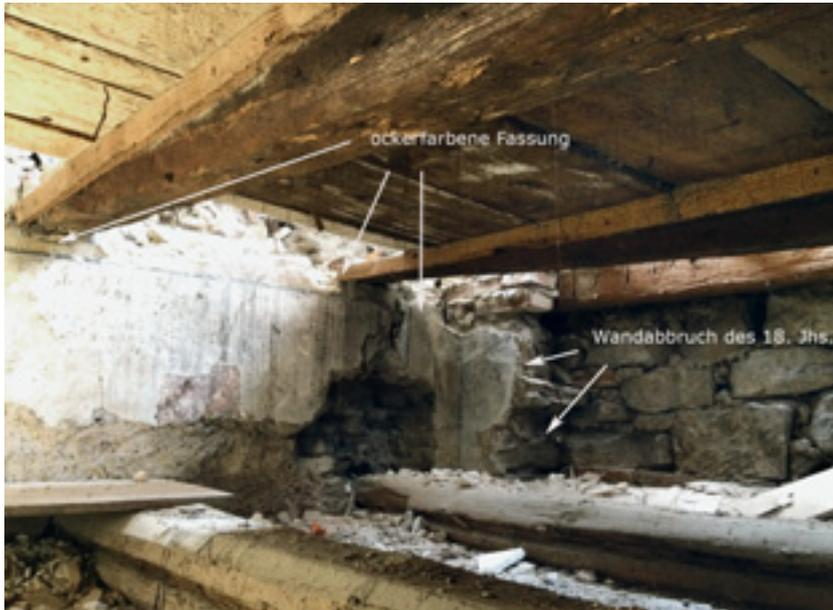
4 Bereich zwischen den beiden Decken im Nordwestraum am Übergang der Westwand zur Nordwand mit Befunden zur bauzeitlichen Ausmalung und der letzten Raumfassung vor Einbau der Barockdecke.
