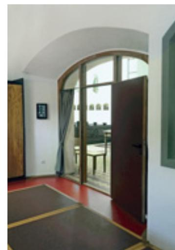
10 Der Schlafraum, das sogenannte „Dormitorium“ der Pilgerherberge. Die Stockbetten stehen an der Trockenwand, die in den Rundbogen der nördlichen Chorwand eingestell ist. Für den Fluchtweg durch das Fenster wurde das historische Gitter zu einem beweglichen Flügel mit Panikschloss umgearbeitet.
