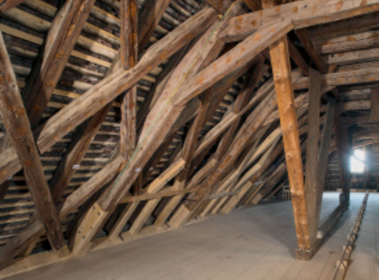
2 Blick in die erste Ebene des Dachwerks in Richtung Nordosten mit einem der erhaltenen Zugstäbe von 1957.
