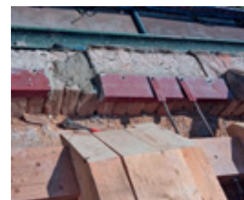
6 Rückverankerung des Traufgesimses während der Bauausführung.
