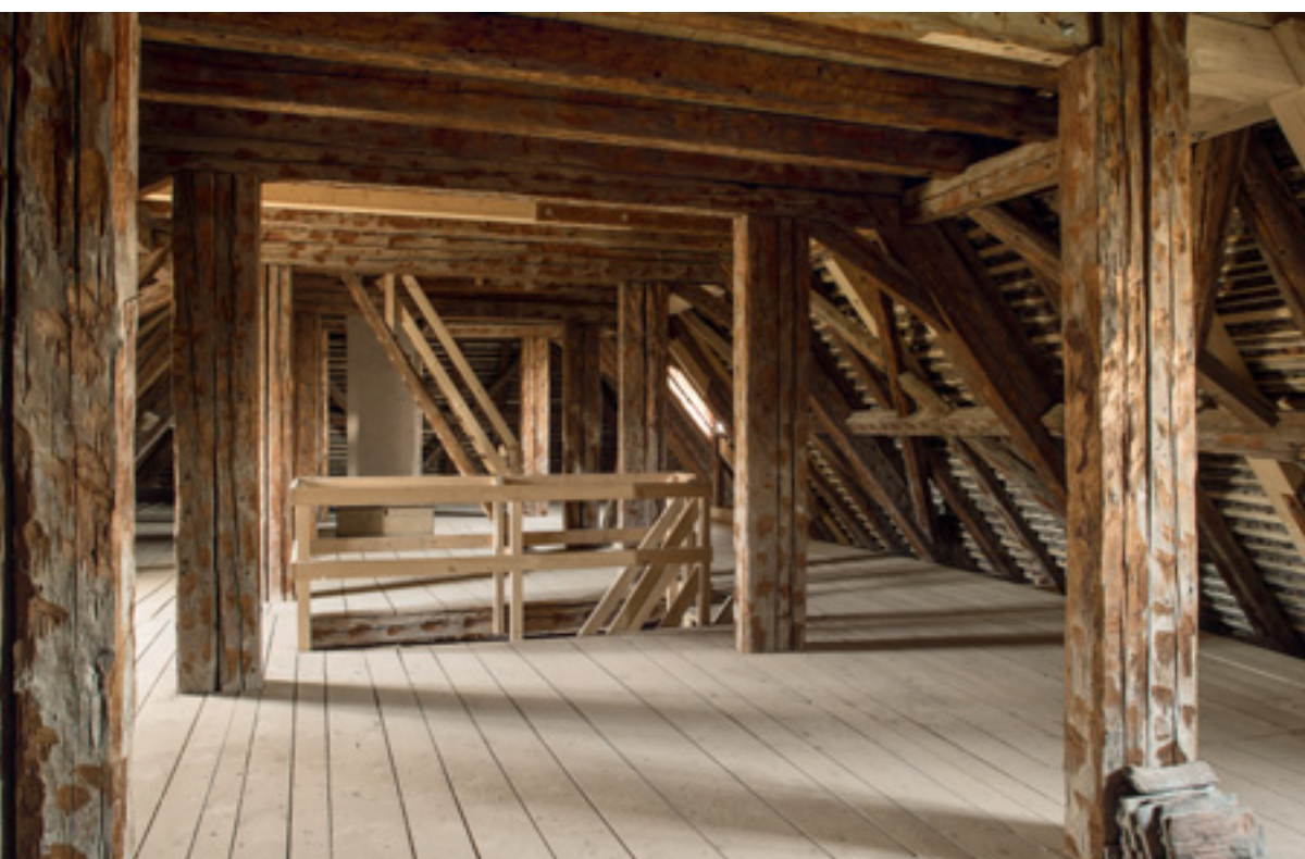
1 Blick in die zweite Ebene des Dachwerks in Richtung Nordosten.
