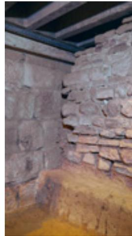
die Mauern des Alten Doms von Mainz sind sogar stellenweise gar nicht fundamntiert, sondern stehen auf dem Fußboden eines Vorgängerbaus. Das Kolloquium hat zum Ziel, in einer überregionalen Zusammenschau diese unterschiedlichen Modelle frühmittelalterlicher Fundamente gegenüberzustellen, um so neue Erkenntnisse über Handwerkstraditionen und bautechnische Konventionen zu erlangen. Dabei wird immer auch nach der Datierbarkeit der Befunde gefragt.
