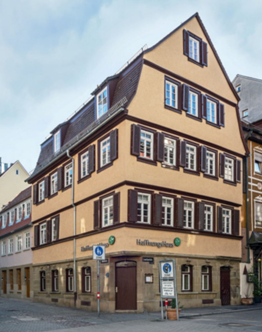
1 Gesamtansicht der Gebäude Jakobstraße 2 und Leonhardstraße 1 nach der Instandsetzung.
