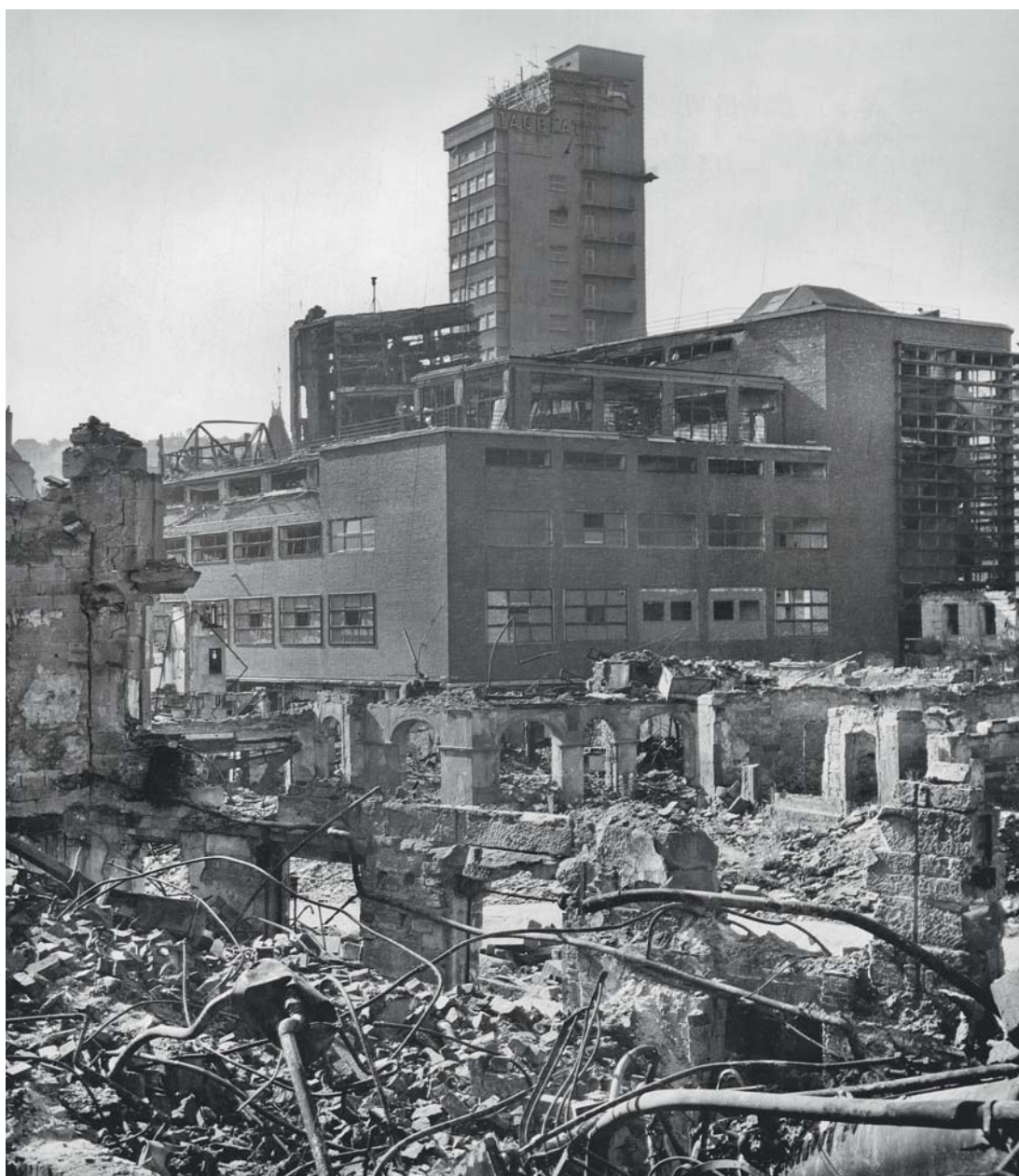
10 Kaufhaus Schocken mit Kriegsschäden von Norden. Im Hintergrund der Tagblatt-Turm, 1944.
