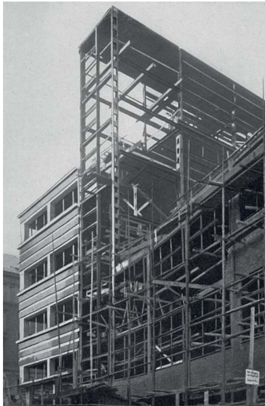
3 Ansicht zur Steinstraße kurz vor dem Abbruch im Mai 1960.
