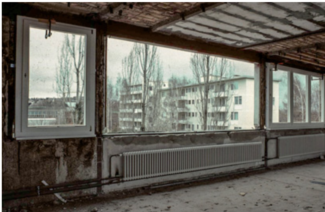
4 Innenraumaufnahme während der Baumaßnahmen, 1984.
