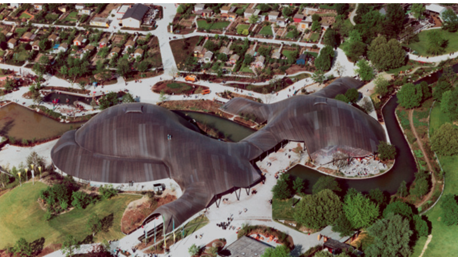
1 Luftaufnahme der Multihalle während der Bundesgartenschau 1975.
