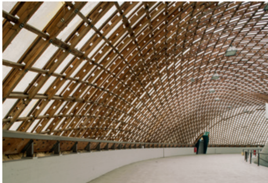
8–9 Gitterschale der kleinen Halle 2016 (oben) und der „Banane“ bei der großen Halle 2019 (unten).
