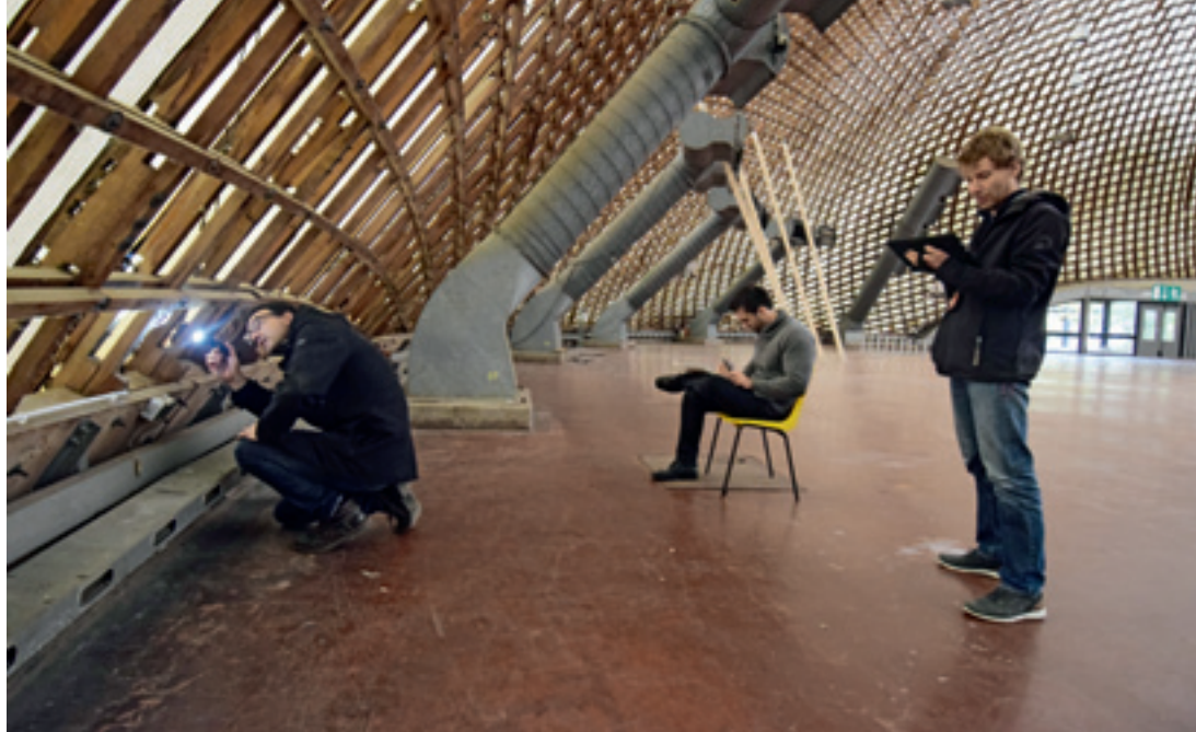
4 Aufnahme vor Ort, von links nach rechts: Befundung am Objekt, händische Kartierung mit Stift auf Papier, digitale Kartierung am Tablet.
