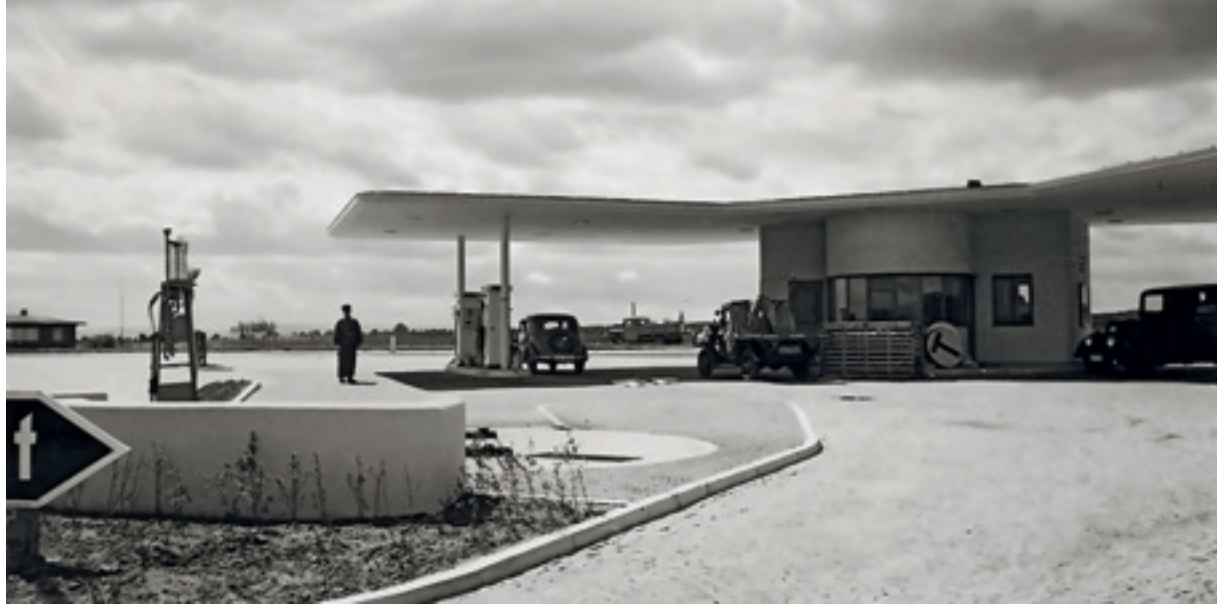
1 Reichsautobahn-tankstelle Stuttgart Süd, Nordseite von Carl August Bembé, 1938.
