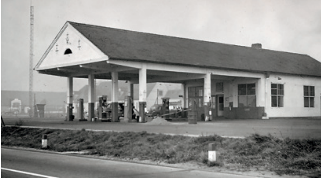
3 Reichsautobahntankstelle Mannheim-Seckenheim von Paul Schmitt- henner, 1938.
