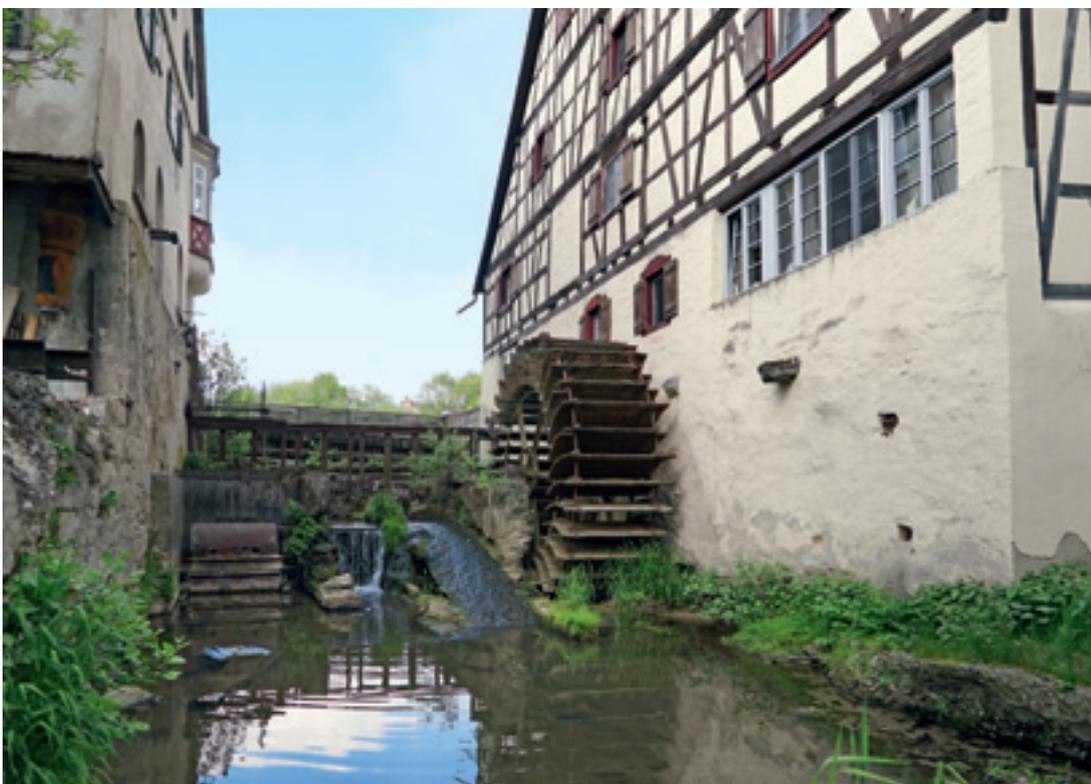
*3* *Die Wasserbauanlage von der Unterwasserseite zwischen den beiden Giebelwänden: rechts die Drehermühle mit großem Wasserrad und links die Kochlinsmühle mit kompakter Turbine.*
