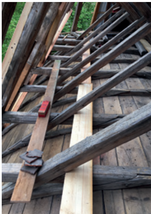
5 Blick in den Dachstuhl und auf die Holztonnengewölbung während der Sanierungsmaßnahme.
