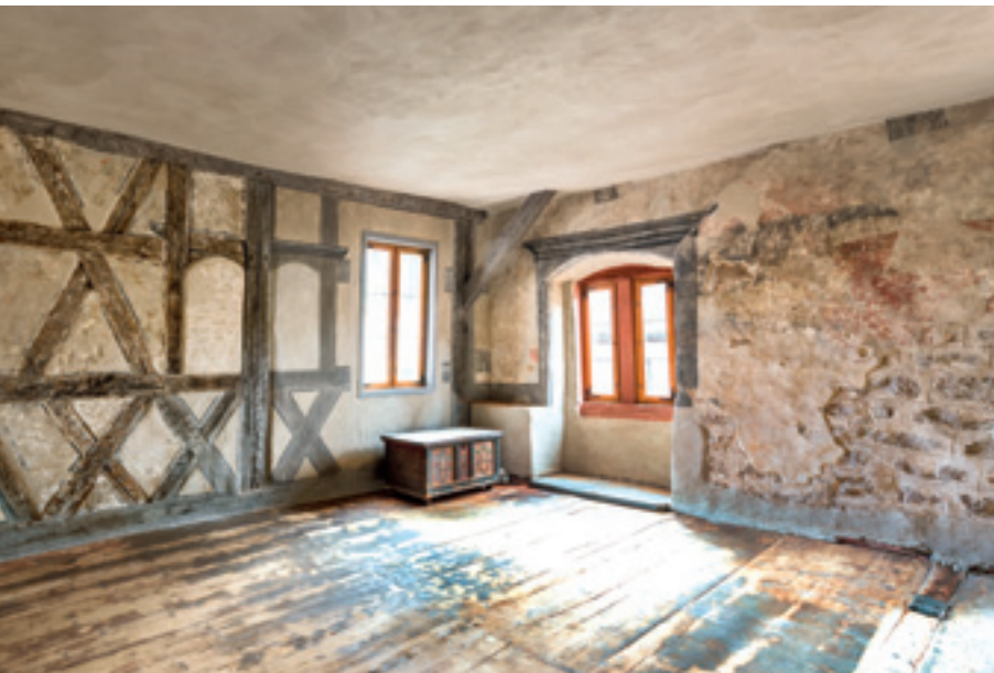
11 Steinhaus, zweites Obergeschoss, südöstliches Eckzimmer mit Farbbefunden des 16. Jahrhunderts, Retuschen und Teilergänzungen. Die beiden segmentbogigen Fensteröffnungen wurden mit Errichtung des Fachwerkhauses 1589 geschlossen.
