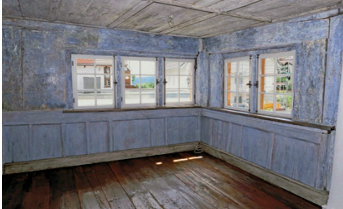
5 Die „Blaue Stube“: Wegen der geringen technischen und gestalterischen Qualität der auf Wand- und Brusttäfer aufliegenden Schichten war die Freilegung und restauratorische Sicherung der stabilen Erstfassung des 19. Jahrhunderts vertretbar. Die Holzfelderdecke ist nach Entfernen der Dispersionsfarbe wieder holzsichtig.
