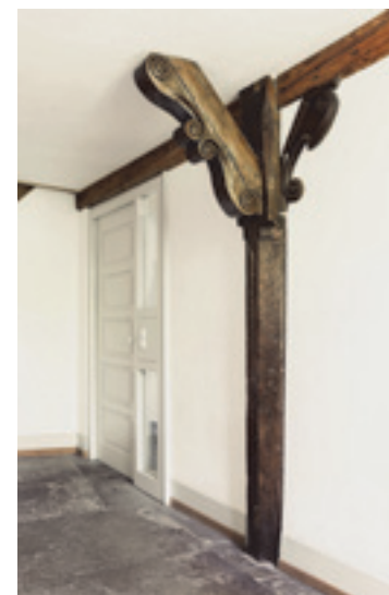
12 Holzpfeiler mit rekonstruierter Kopfstrebe im ersten Obergeschoss, Treppenhausflur.
