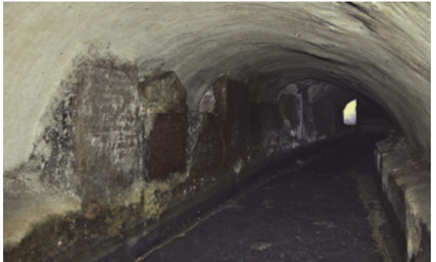
4 Gedenktafeln der Bauherren im Freiburger Bächlestollen.
