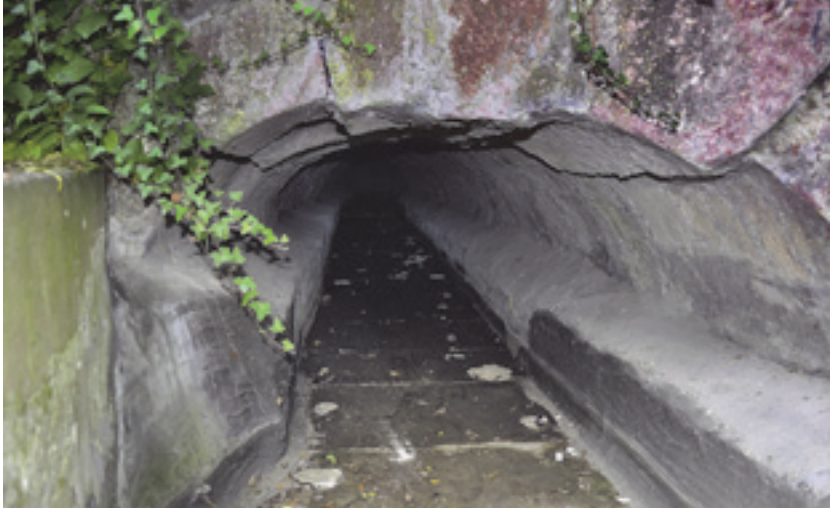
3 Blick in den überwölbten Bächlestollen im Freiburger Schlossberg.
