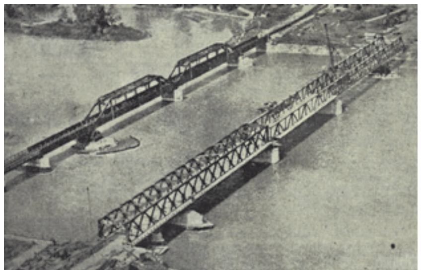
14 Kehl–Strasbourg: Eisenbahn- und Straßenbrücke, Luftbild nach 1951.
