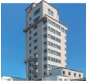
Der Tagblattturm mit neuen denkmalgerechten Fenstern vom Dach eines Hofgebäudes gesehen, Zustand 2020. Foto: RPS-LAD, Iris Geiger-Messner.
