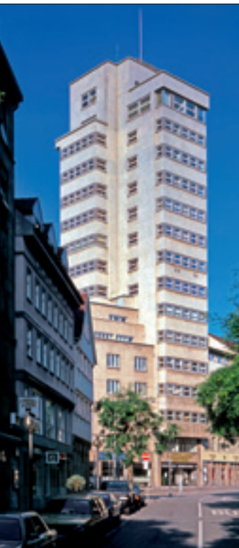
13 Der Tagblattturm nach Verputz der Fassaden und Entfernung der originalen Schiebefenster in den Jahren 1977/79, Zustand 1996.
