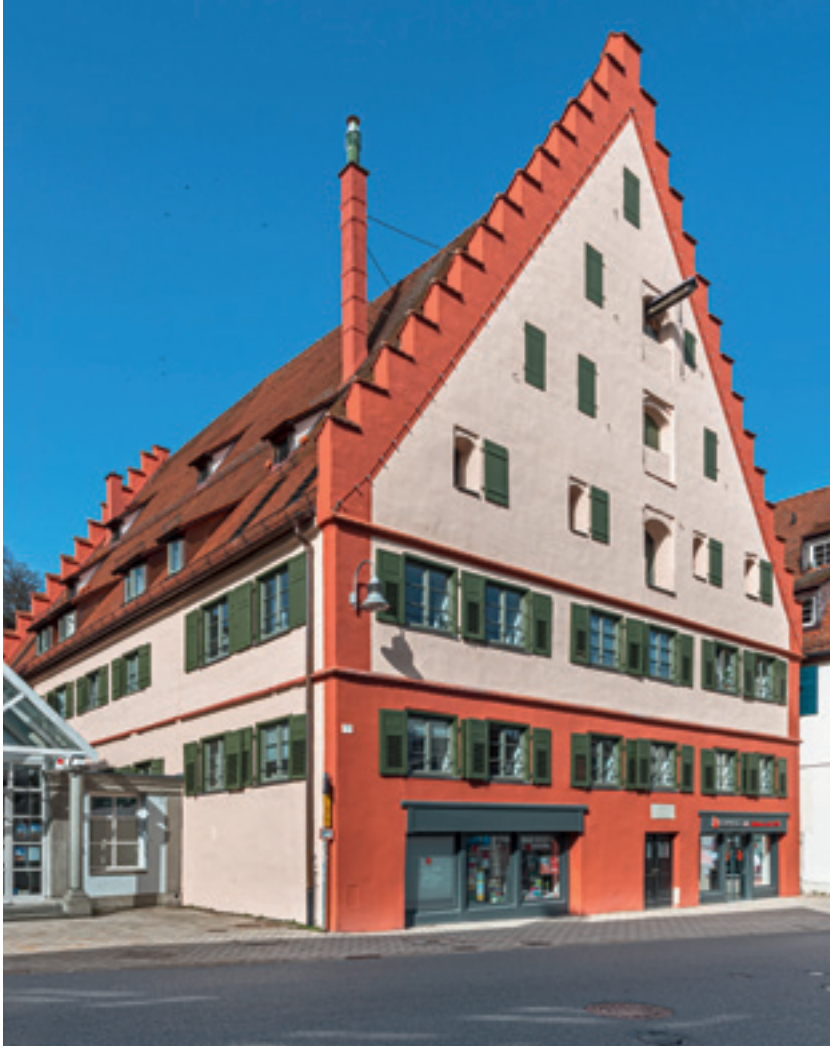
2 Die Giebelseite des Salzstadels am Holzmarkt nach Instandsetzung und Umbau 2019.
