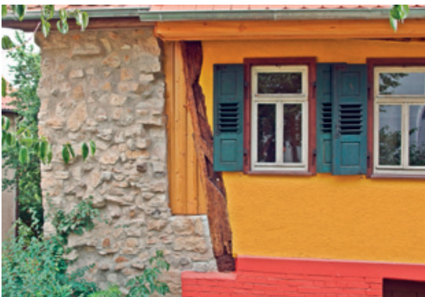
5 Fassadendetail nach Instandsetzung mit Bruchkante der Stadtmauer und spätmittelalterlichem Eckständer mit Blattsassen im Jahr 2017.
