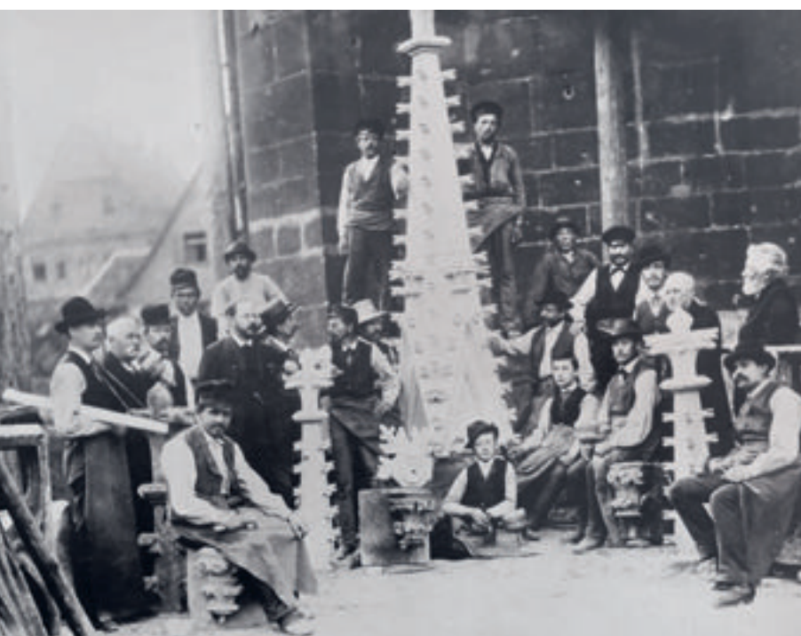
1 Bauhüttenmitarbeiter in Schwäbisch-Gmünd, um 1888.
