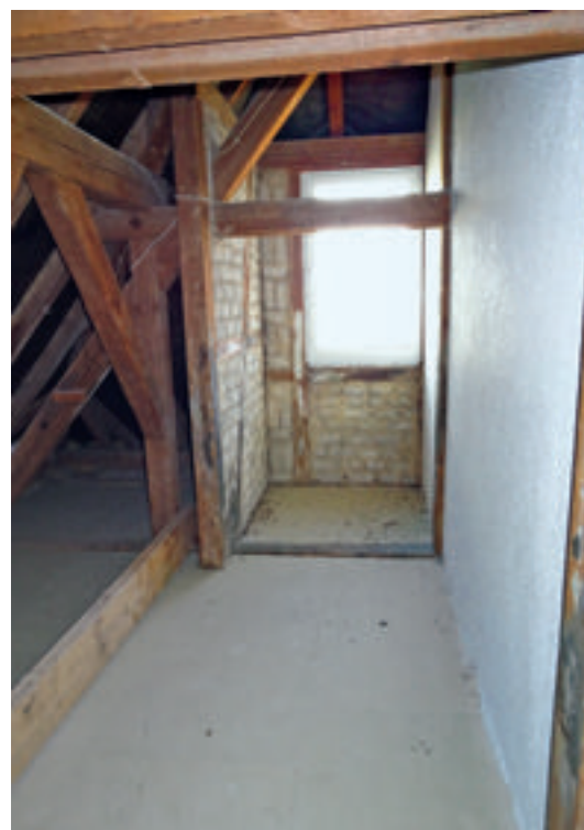
4 Arrestzelle in Gebäude 19 im aktuellen Zustand.
