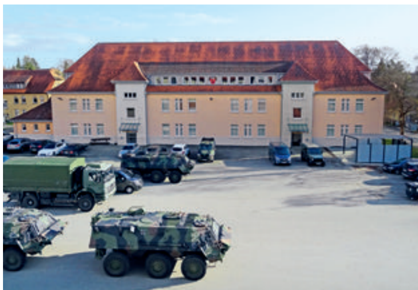
2 Gebäude 23 im aktuellen Zustand.
