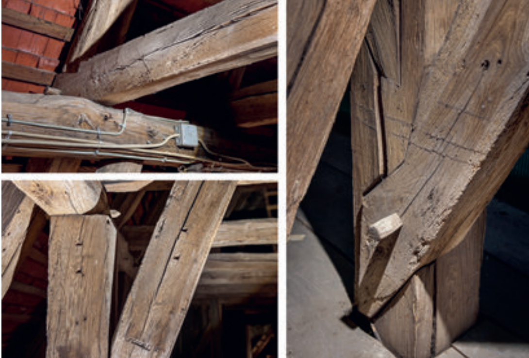
8 Abbundzeichensystem an Hölzern des Langhauses.
