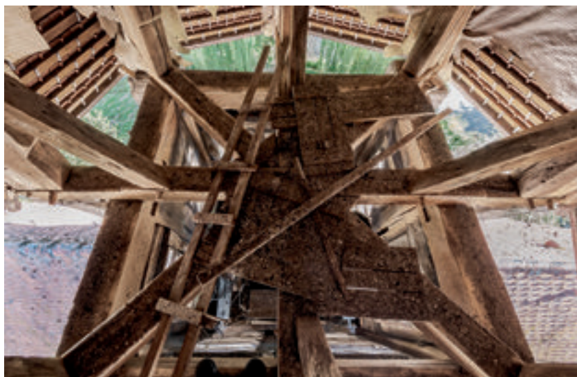
7 Blick auf den Traufbereich des Dachreiters.
