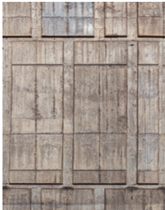
6 Reliefartig wechselnde, rechteckige Felder strukturieren die Fassade der Hufeisenwand.
