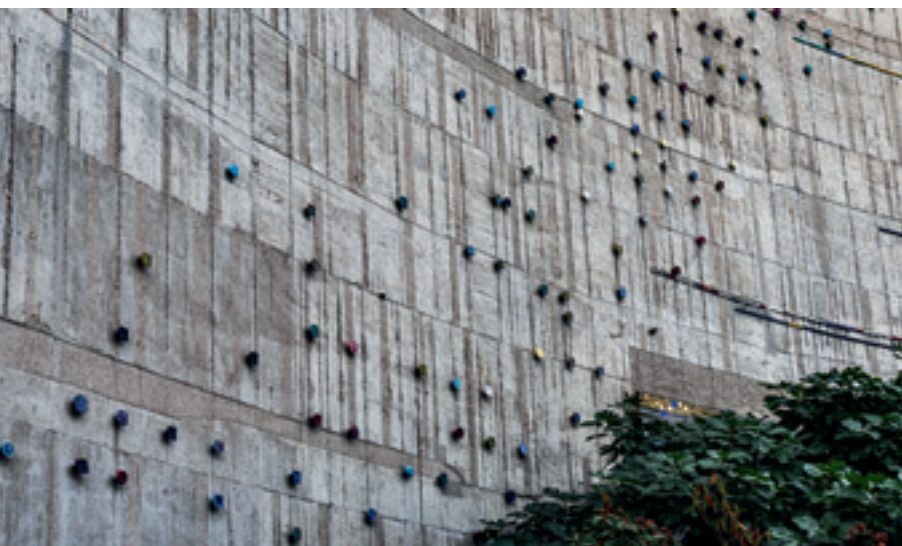
9 Die konkave Außenwand des Beethovensaals mit glasierten Keramikknöpfen.
