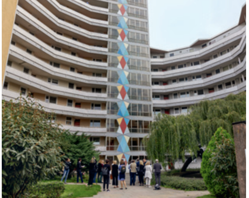
11 Das hier sichtbare Hochhaus Julia mit seinen Laubengängen erfordert von der Denkmalpflege den Einsatz neuer innovativer Sanierungsmaßnahmen.
