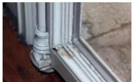
historische Gebäude eine ausreichend große Luftundichtheit aufweisen. Wird das vorhandene historische Glas bei der Herstellung der neuen Isolierverglasung als äußere Scheibe wiederverwendet (Abb. 12), verbessert dies die Akzeptanz des Glasaustauschs bei Bauherren und Konservatoren.
