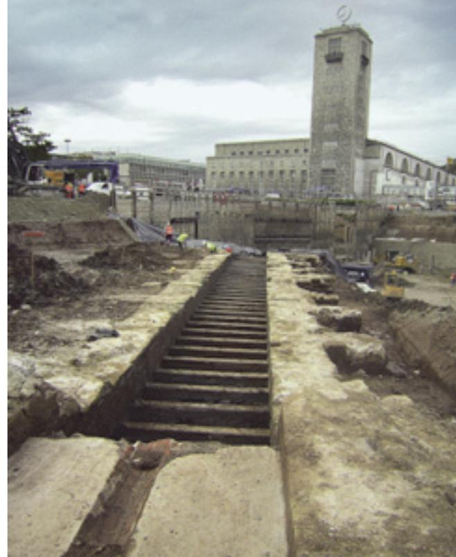
balken der Querhölzer des Balkenrostes Fälldaten in den Jahren 1817 und 1818 und für einen der Stützpfeile aus Eiche mit 1807 einen etwas früheren Zeitpunkt.
