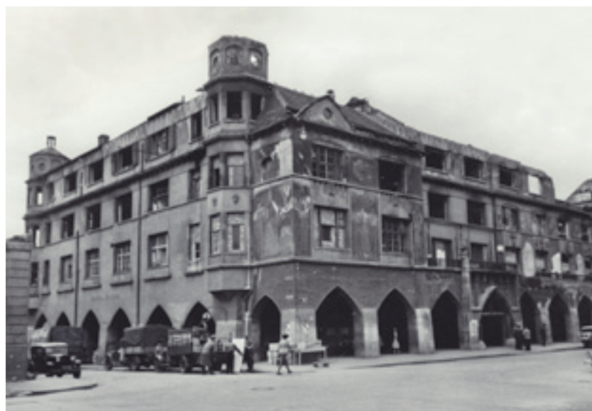
3 Die Markthalle im Jahr 1949 zur Ecke Karlsplatz/Münzstraße mit Kriegsschäden auch an den Fassadenbildern.
