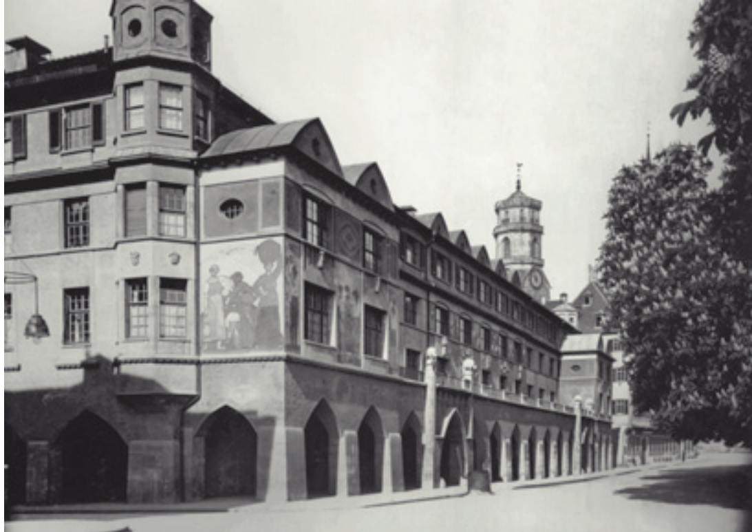
2 Die Markthalle von der Ecke Karlsplatz/Münzstraße mit Wandbild des Franz Heinrich Gref, Zustand im Sommer 1914.
