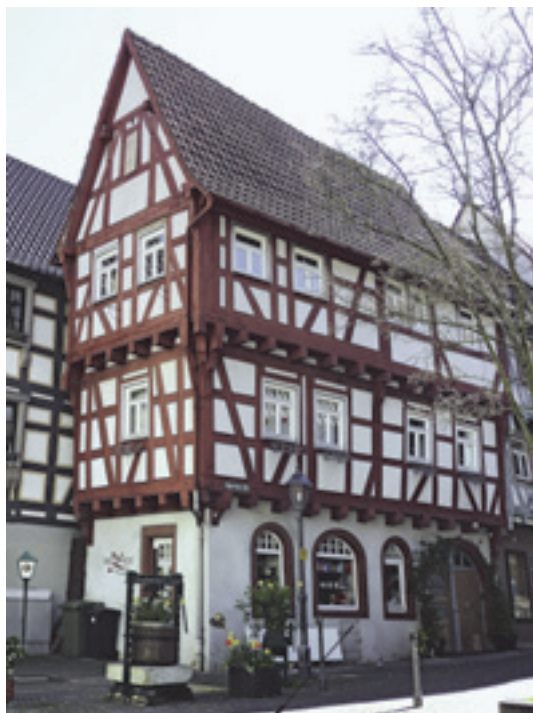
3–4 Das Wohn- und Geschäftshaus Alper-turmstraße 10 (links) und das Gebäude in der Pfarrgasse 10 (rechts).
