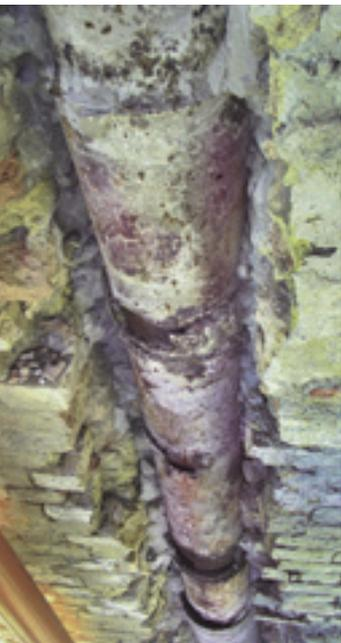
2 Eiserne Fallrohre mit Muffenverbindung.
