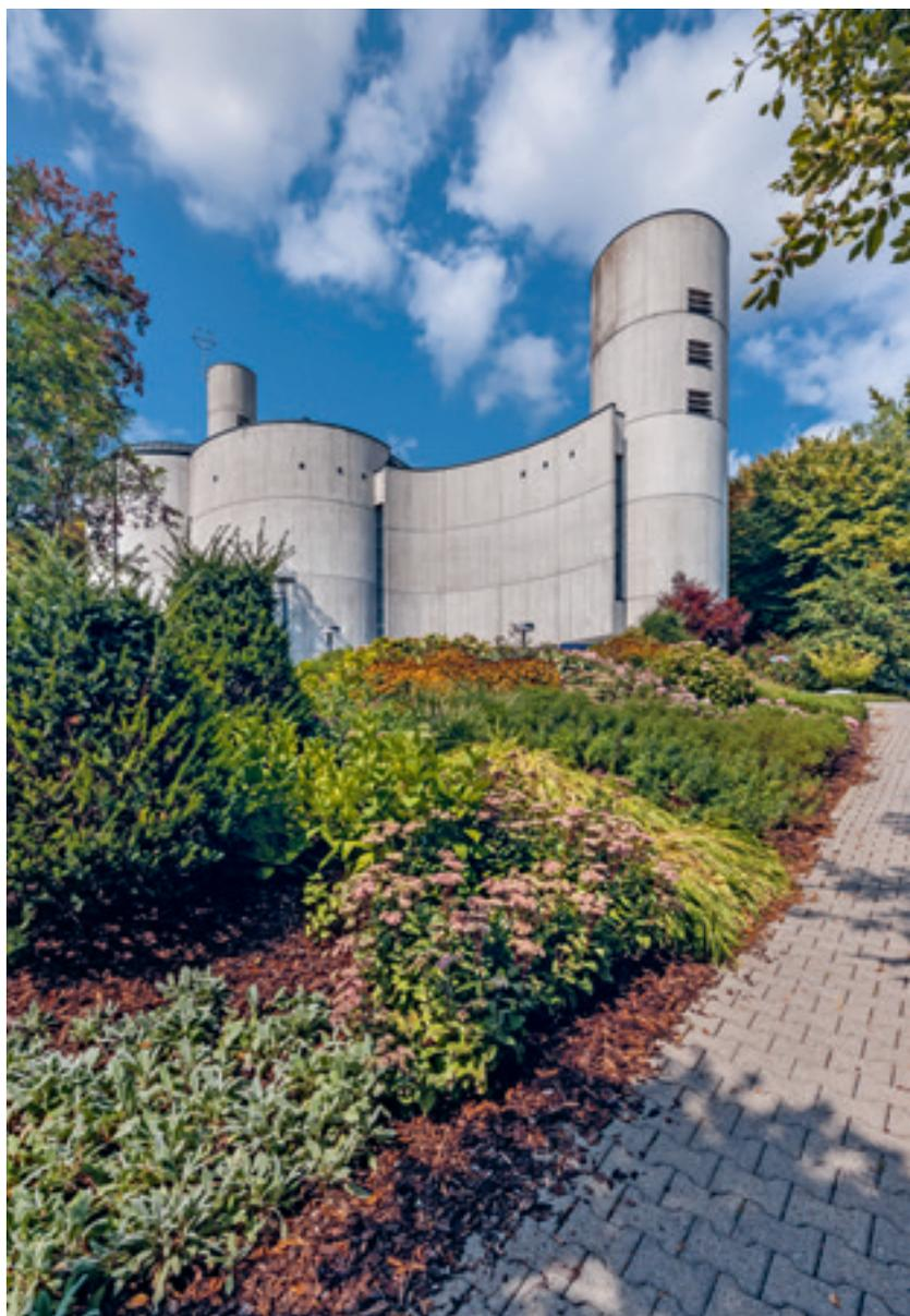
gerundeten, teils konkaven oder konvexen Außenwänden. Der Entwurf stammt aus der Feder des schweizerischen Architekten Hermann Baur. Schalungrauer Sichtbeton mit Abdrücken der Brettschalung zeugt vom planerischen und handwerklichen Anspruch. Im Gegensatz zum fortifikatorischen Äußeren der geometrischen Architektur steht der helle Innenraum. Charakteristisch für den Kirchenbau der Nachkriegszeit ist die geschickte Wegführung durch Licht: Über einen dunklen Eingangsbereich erreicht man das Innere.
