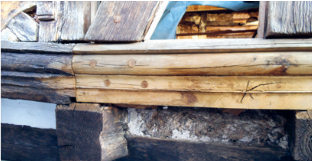
6 Reparatur der Schwellenprofilierung unterhalb der Fenstererker.
