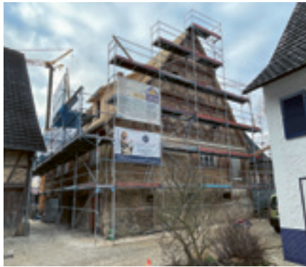
2 Denkmalgeschütztes Wohnhaus in der Bahnhofstraße in Eutingen.
