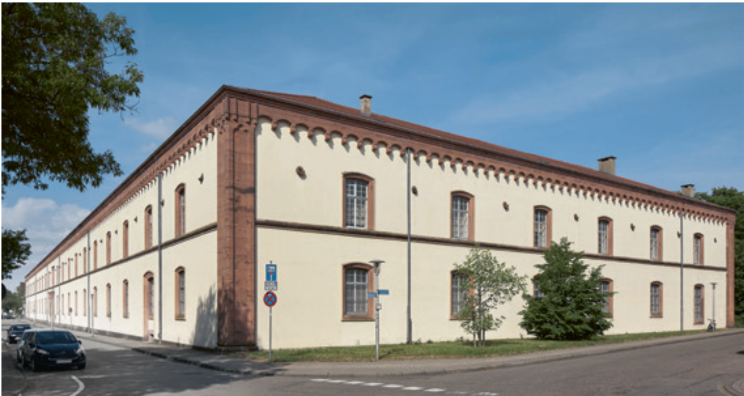
1 Das Gebäude des Zentralen Fundarchivs in Rastatt (ehemaliges Lazarett der Bundesfestung Rastatt).
