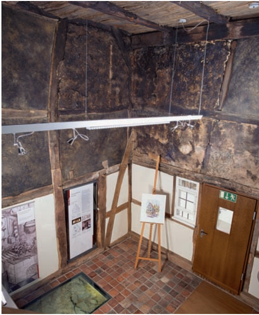
4 Die Küchensituation als Rekonstruktion um 1458. Der Rauch stieg von der gemauerten Herdstelle in den zweigeschossigen Luftraum und dann über zwei Öffnungen in der Deckenbalkenlage bis zum Dachspitz. Vermutlich war an der Außenwand der Küche ein Backofen angebaut, der aber nicht durch Befund nachgewiesen werden konnte, da bezeichnenderweise dieser Wandabschnitt erneuert worden war.
