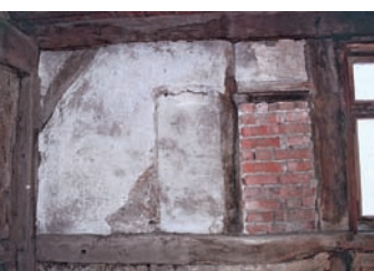
13 Die Aussparungen im Lehm zeigen die ehemals vorhandenen Schiebläden an.
