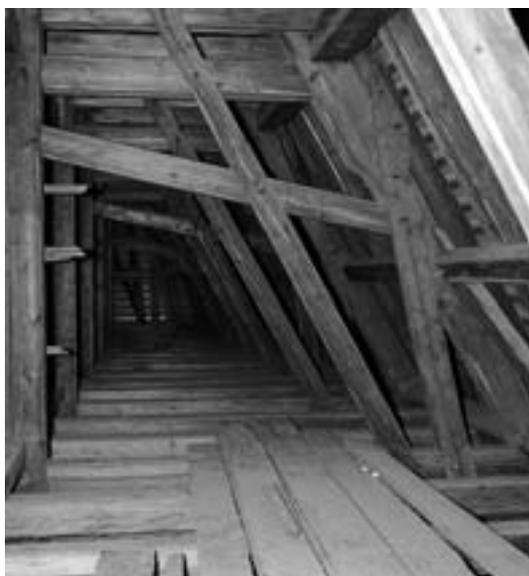
1 Breite, sehr steil verlaufende Fußbänder fixieren die liegenden, aus gesägtem Eichenholz gefertigten Stuhlstände im Chordachwerk.
