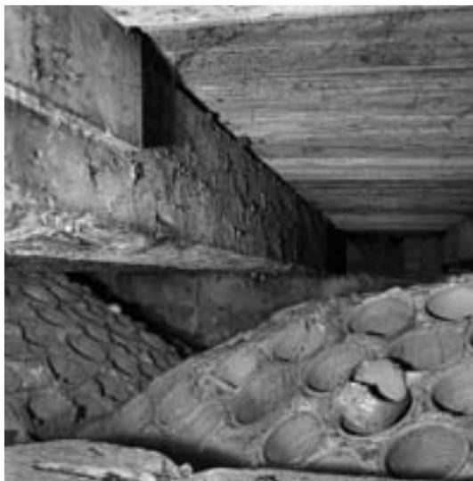
13 Gewölbeschale aus Tontöpfen, meist mit Sägespänen oder Torf verfüllt.
