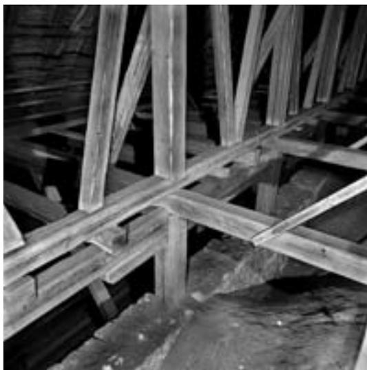
17 Dachgeschoss über dem Mittelschiff, ausgebauter Kehlbalken und ausgeschnittene Schwelle.
