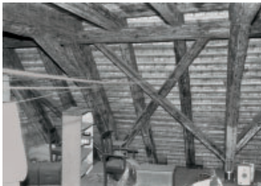
1 Blick in den Dachstuhl des 18. Jahrhunderts mit den markanten Andreascreuzen. Die Aufnahme erfolgte im Rahmen der Inventarisierung 1987.
