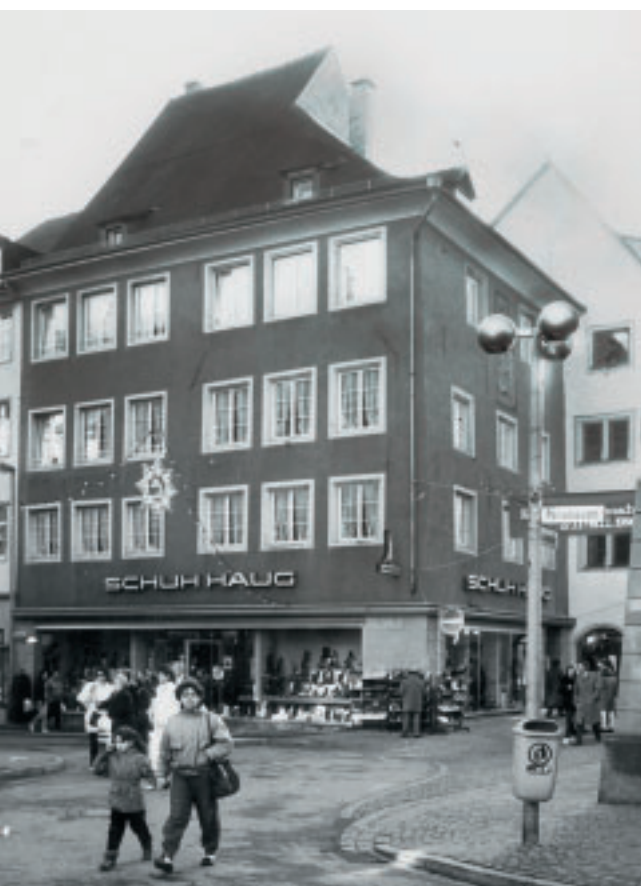
2 Außenansicht des Gebäudes Hussenstraße 1, die während der Inventarisierung 1987 angefertigt wurde. Die Zweiteilung des Hauses ist an der Fensterordnung und der Dachform ablesbar.
