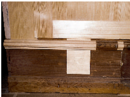
6 Johann Georg Schäfer-Orgel (1832): Zerschnittener Sockelrahmen des historischen Orgelgehäuses, bedingt durch den Umbau von 1974.
