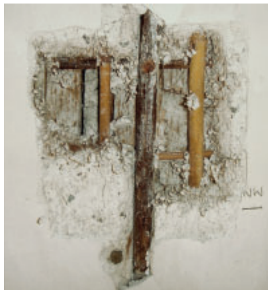
3 Sondage zum Deckenaufbau.
