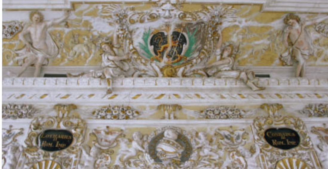
14 a + b Südlicher Wandbereich mit Wappen oberhalb der Voute im Vorzustand 2006 und nach der Restaurierung 2011.
