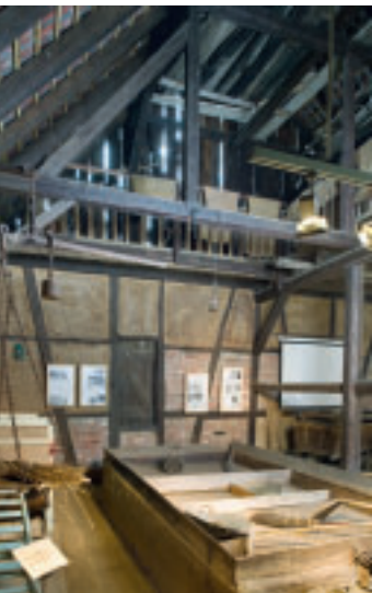
7 Blick in die Museumsdarre mit Darrblech und offenem Dachstuhl, durch den beim Gären der Rauch über Luken in den Giebeln abzog.
