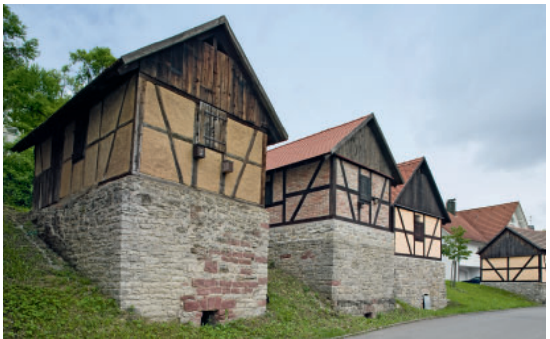
3 Blick auf die Darren in Hanglage.
