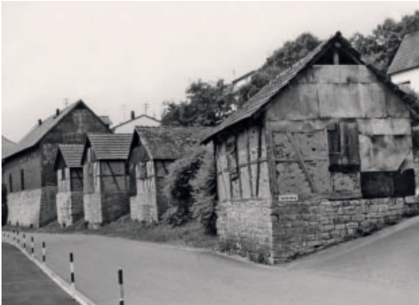
11 Die Darren vor der Sanierung.
