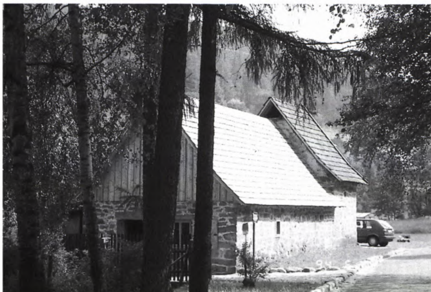
■ 5 Die Rußhütte nach Abschluß der Arbeiten von Norden.
