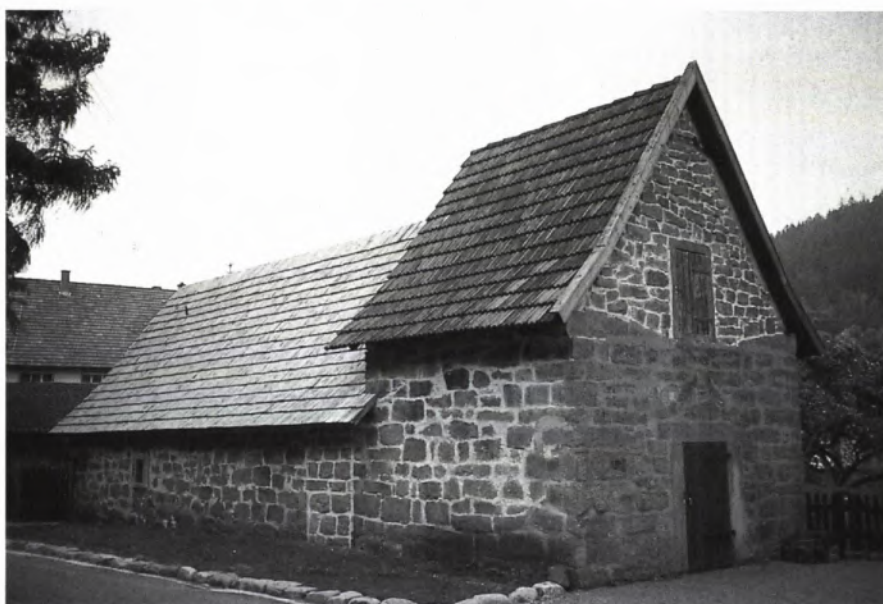
■ 6 Die Rußhütte nach Abschluß der Arbeiten. Blick auf den erhöhten ziegelgedeckten Filterraum.
