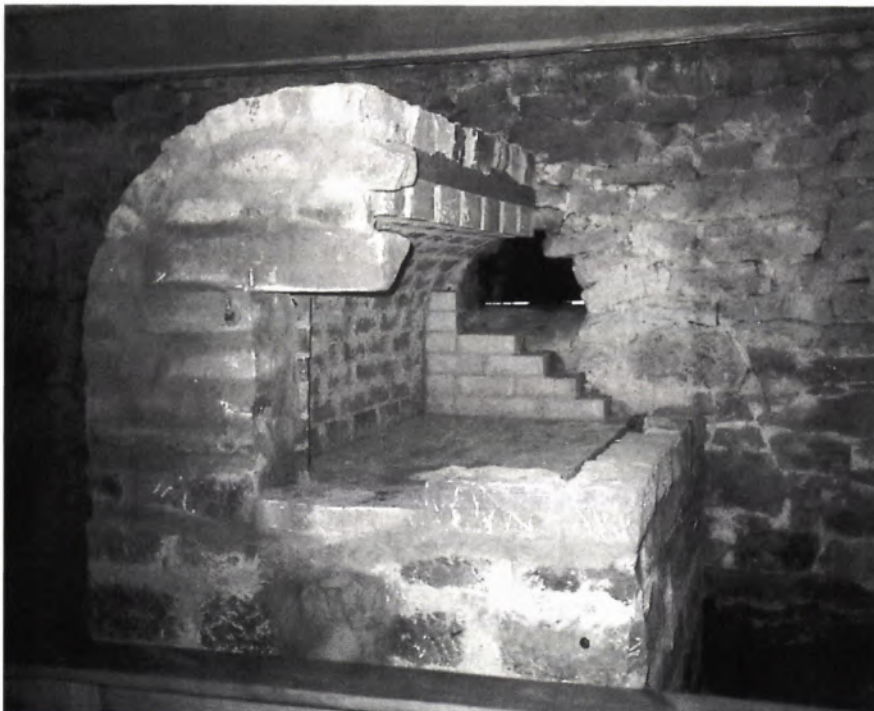
■ 4 Das rekonstruierte Ofengewölbe im Brennraum. Der Längsschnitt läßt die Funktion der Brennkammer deutlich erkennen.
