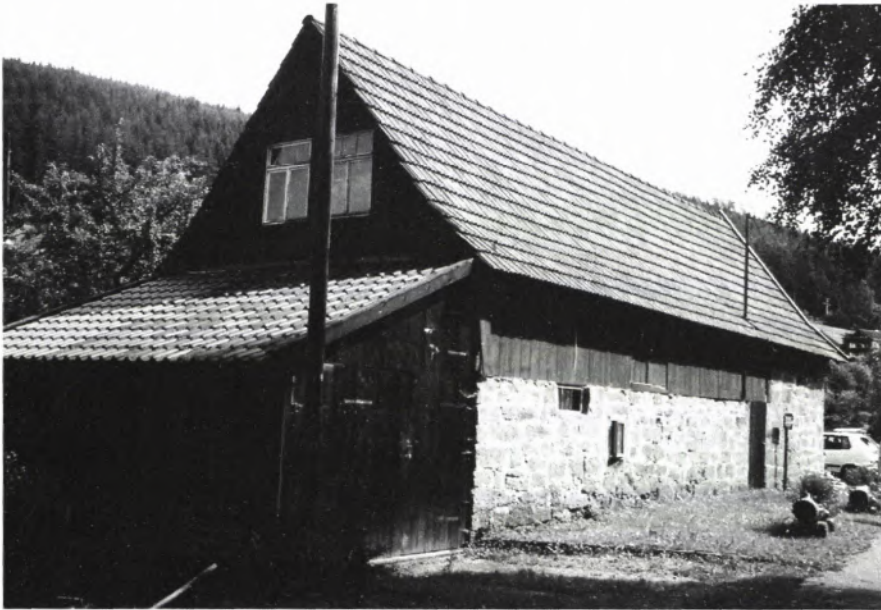
■ 1 Die Rußhütte in Enzklösterle vor dem Beginn der Sanierung. Ansicht von Norden.
