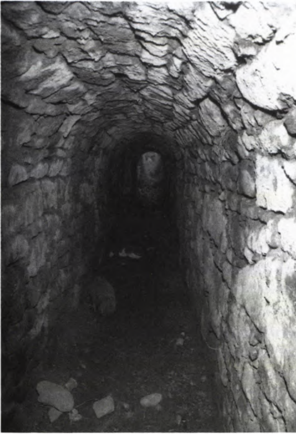
3 GEWÖLBE des Pirschganges vor der Sanierung von 1986.
