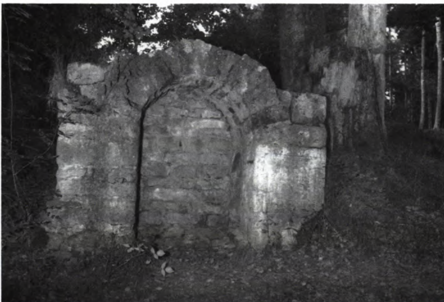
1 EINGANG zu den Pirschgängen von der Planklinge aus. Der Bogen, der in jüngster Zeit vermauert wurde, trägt die Bauinschrift des Jahres 1737.
