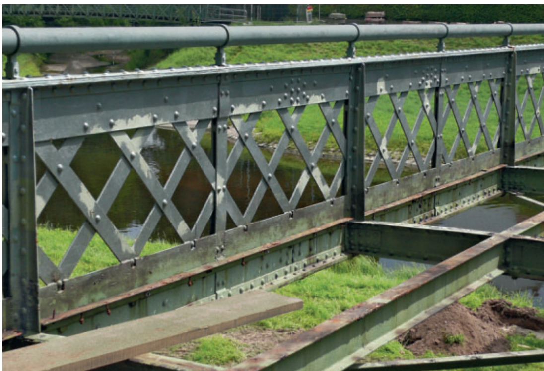
3 Historisches Tragwerk (1866) mit später eingebauten Teilen.
