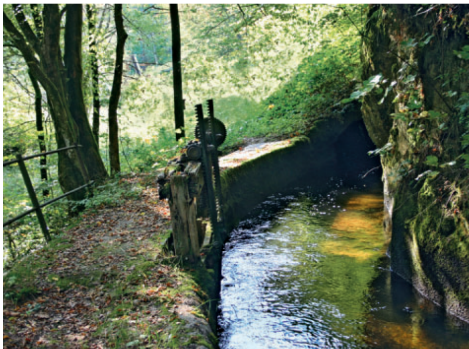
10 Der parallel zur Alb geführte Hangkanal („Betriebskanal“).
