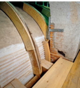
8 Dachraum, Blick auf die zurückgeschnittenen und mit Metallschuhen an den Wandpfeilern befestigten Schiffsgewölbespannten.
