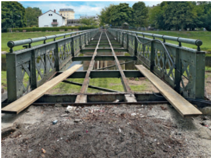
1 Rohrersteg nach Abbau des hölzernen Bohlenbelags (Juni 2008).
