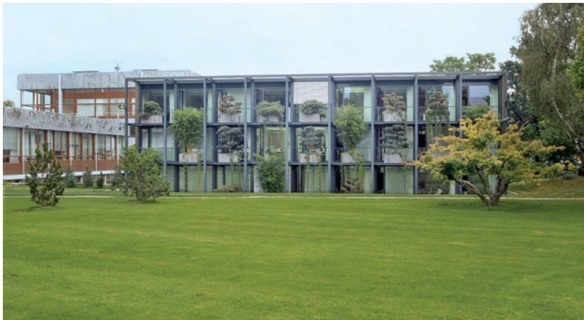
9 Richtergebäude, Blick in den Hof.
