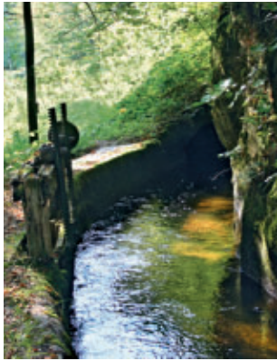
Hangkanal in Tiefenstein (Foto: S. Schellberg)
