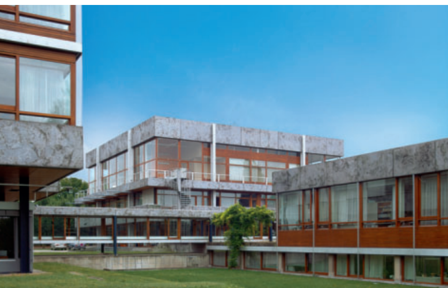
1 Bundesverfassungsgericht, Sitzungsgebäude (Mitte), Richtergebäude (links), Bibliothek (rechts).
