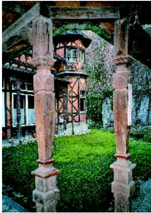
2 Rottenburg-Bad Niedernau, ehemalige Villa Steiner, hölzerner Wandelgang und Speisesaalgebäude.
