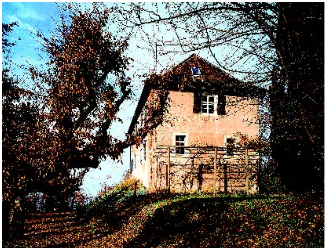
19 Blick von Osten in den Hainbuchengang, die Ostfassade des Wohnhauses heute ohne „tütenblauen Freskenhimmel“, Zustand Frühjahr 2002.
