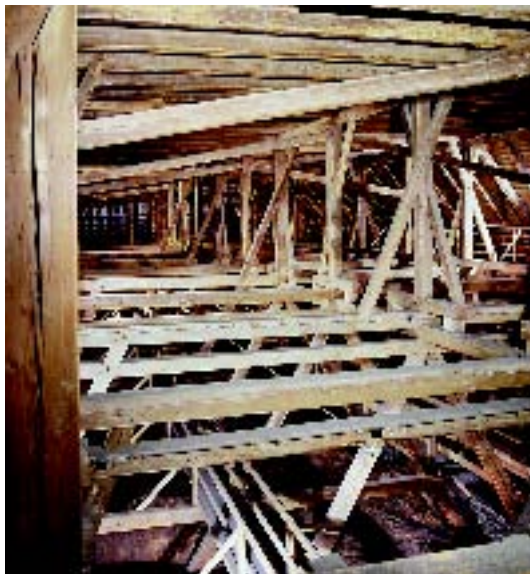
1 Langhausdachwerk, errichtet 1489/90, drittes Dachgeschoss nach Ost mit Blick auf das 1866/67 unter Baumeister Christian Friedrich von Leins eingebaute Gewölbe.
