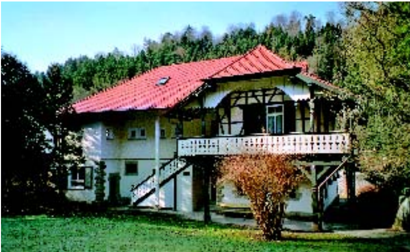
4 Rottenburg-Bad Niedernau, ehemalige Villa Steiner, Wohn- und Wirtschaftsgebäude im unteren Garten.
