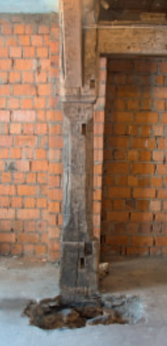
7 Profilierte Eichenstütze und Kopfsteinpflaster im Erdgeschoss.
