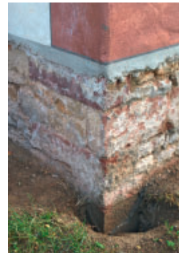
5 Riegel, Michaels- kapelle. Ansicht des ver- mauerten rundbogigen Portals in der Nordwand.
