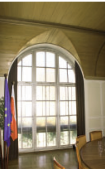
17 Winterlingen, Marktstraße 1, Rathaus. Bleiverglastes Flachkastenfenster im Ratssaal als Stahl-Aluminium-Konstruktion.
