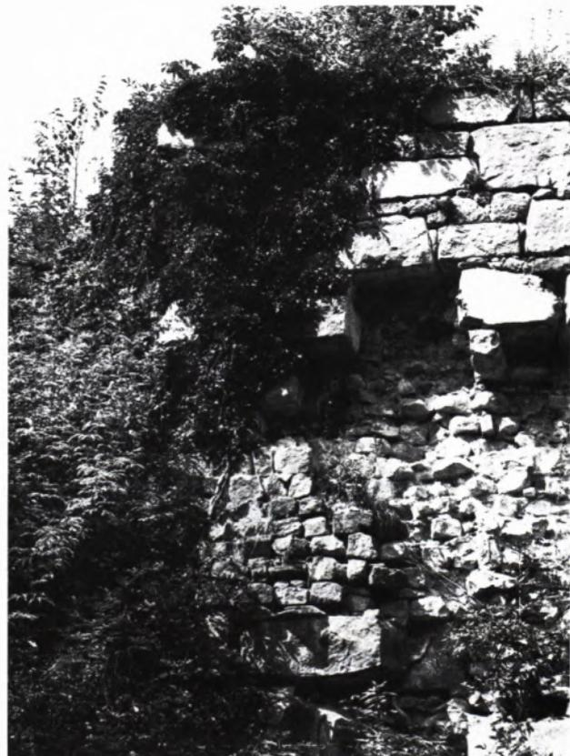
3 DURCHBRUCH an der Palas-Nordwand durch die 2 Meter dicke Wand unter dem Rundbogenfenster.
