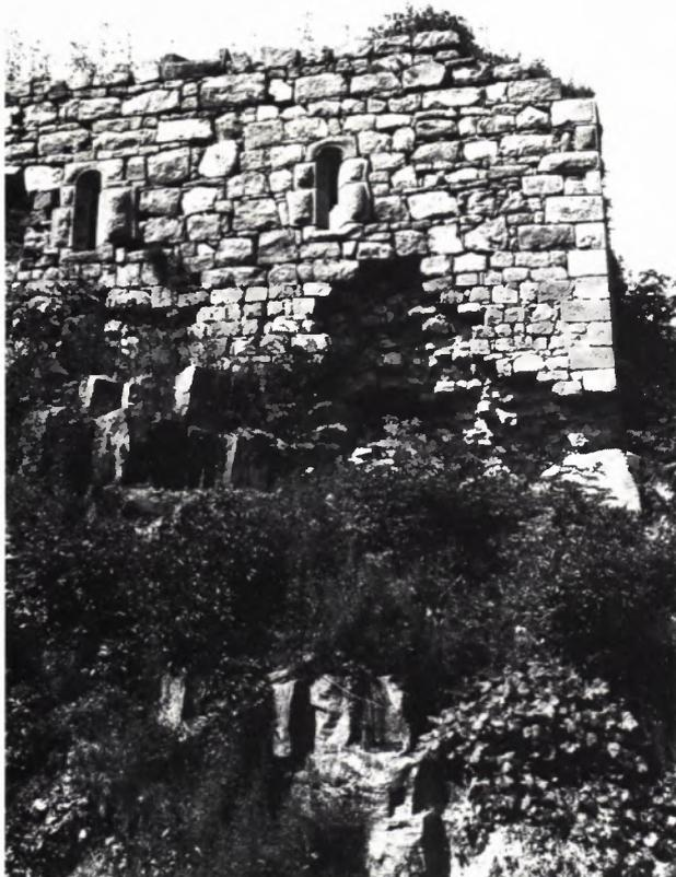
5 DIE NORDWAND nach der Sanierung mit erneuertem Fenstergewände.
