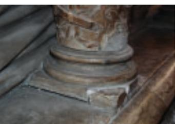
chinbereich nur zu leichter Kontaktkorrosion am Eisen geführt hatte. Auch dort, wo durch starke Feuchteaufnahme das Eisen fast komplett korrodiert war, führte die Volumenzunahme lediglich dann zu Schäden durch Rostsprengung, wenn nur wenig Gipsmörtel den Eisendübel umgab beziehungsweise der Eisendübel eng am Dübelloch anlag. An größer gearbeiteten Dübellöchern konnte der weiche Gipsmörtel nachgeben, sodass es zu keiner Rostsprengung am Alabaster kam.
