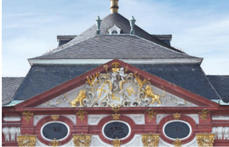
borns halten zwei Putten den Fürstenhut. Oberer Abschluss der Darstellung ist der aus Blech gefertigte Kardinalshut. Im Hintergrund erkennt man rechts das ebenfalls aus Blech hergestellte Schwert und links den Bischofsstab als Insignien weltlicher und geistlicher Macht.
